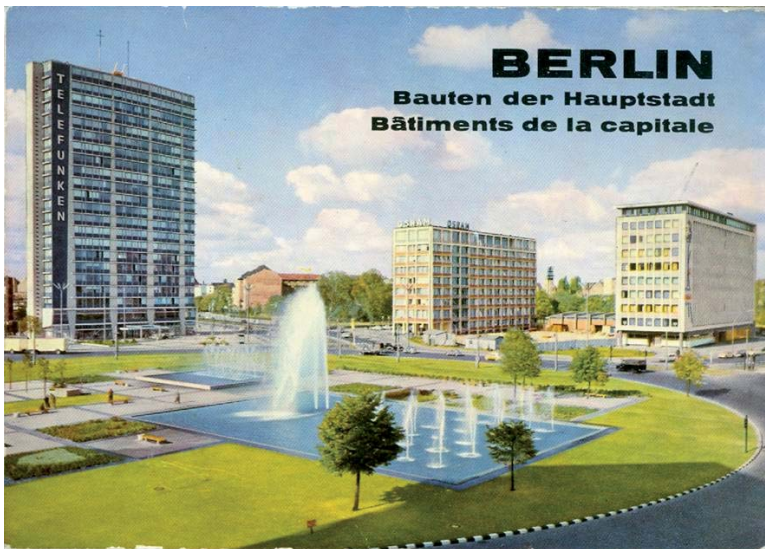
Umschlag einer Postkartenserie der Senatsbauverwaltung, in der Mitte das Osram-Haus, links das Telefunken-Haus, rechts das Pepper-Haus, 1962
